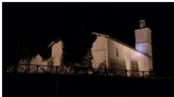
La chiesa *"è stata sventrata, le campane suonavano a distesa sotto le scosse, ma non possiamo accusare nessuno: i lavori fatti nel '97 hanno evitato il collasso della struttura, e il cordolo fissato all'altezza del cornicione ci ha concesso il tempo di fuga"* le hanno spiegato i pompieri. Da una settimana le sei monache di clausura vivono nella foresteria delle clarisse di San Severino Marche,
